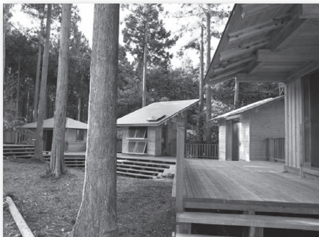
「いこいの森」には「よせぎの家」のモデルとなるバンガロー5棟とウッドデッキ
