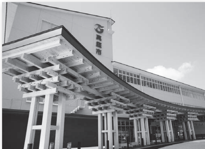
真庭市役所本庁舎(平成23年3月完成)
