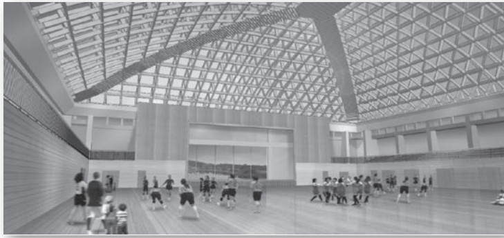
五條総合体育館（平成28年秋完成予定）：県南部の杉材を使って住宅レベルの集成材で立体トラス架け約50mスパンを実現
