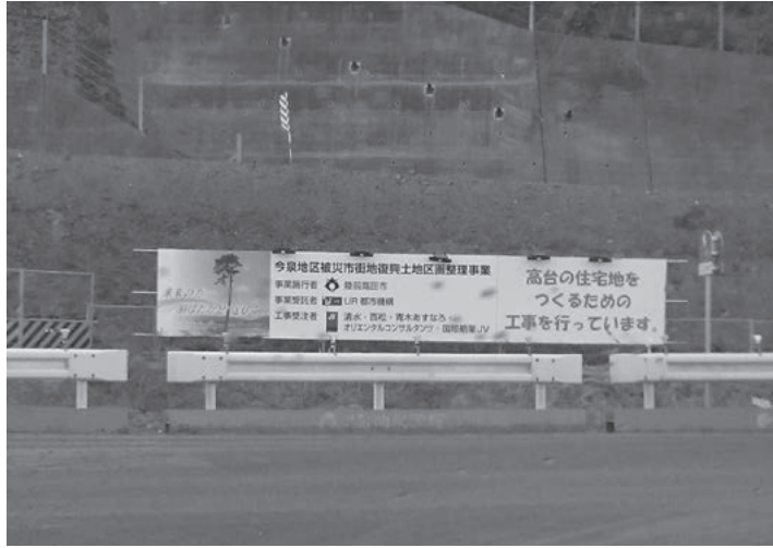
高台造成が続く陸前高田市の今泉地区(平成28年3月25日 鍵屋撮影)
