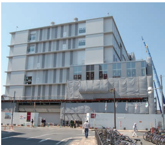
建設中の市立病院
