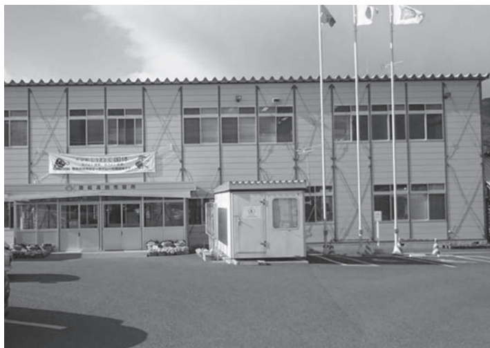
陸前高田市役所のプレハブ仮庁舎(平成28年3月25日 鍵屋撮影)
