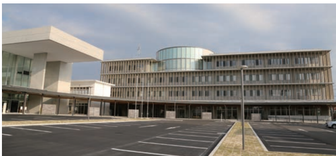
新しく整備した市庁舎(右)。他施設と庇のついた「くにさき回廊」でつなぐ構造が特徴(国東市)
