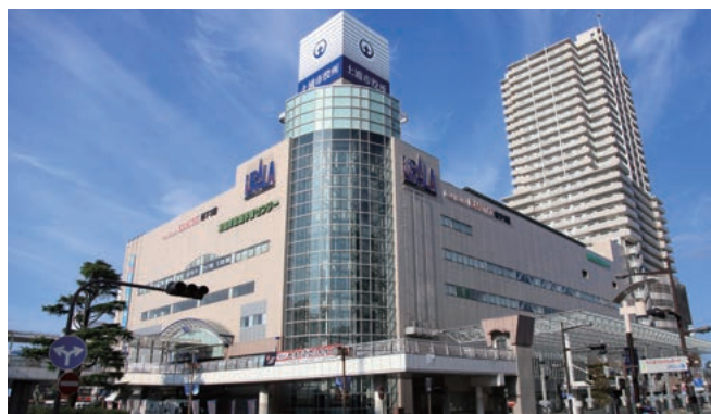
撤退した駅前商業ビルを改装した上で、新庁舎に整備。中心市街地活性化の起爆剤としても期待(土浦市)
