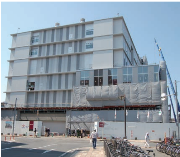
建設中の市立病院
