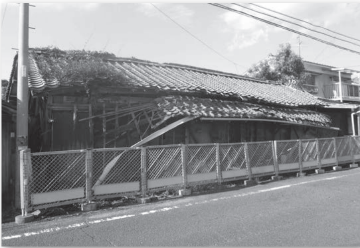
小学生の通学路にあり、倒壊すれば重大な事故につながる恐れがある空き家
