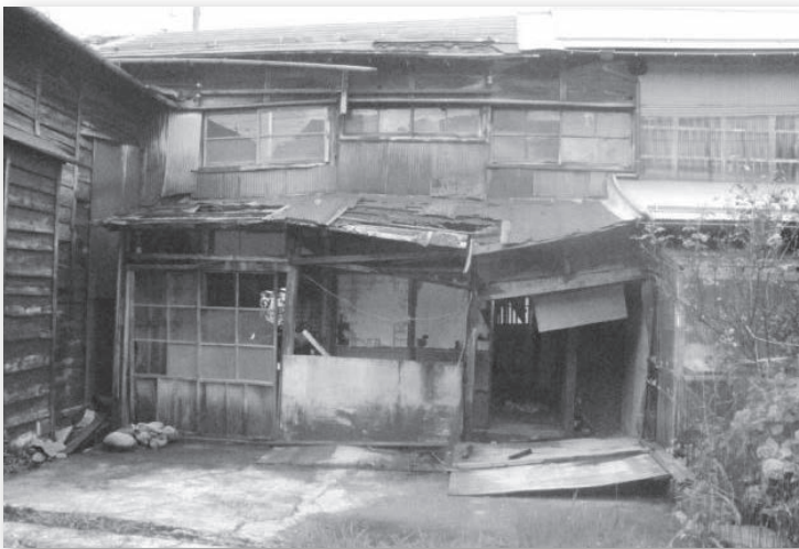
対策が必要な空き家
