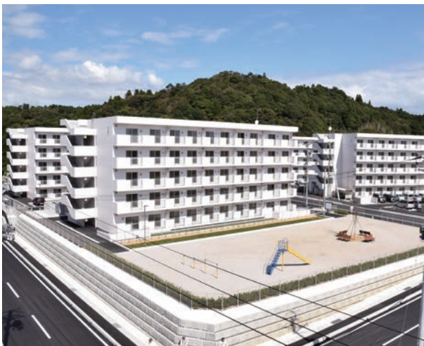
全工事が完了した災害公営住宅。全戸が入居可能な状態に
