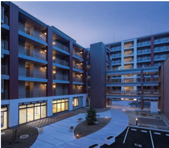
市内で整備が進む復興公営住宅
