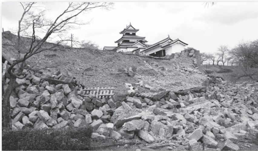
崩落した本丸南面石垣
