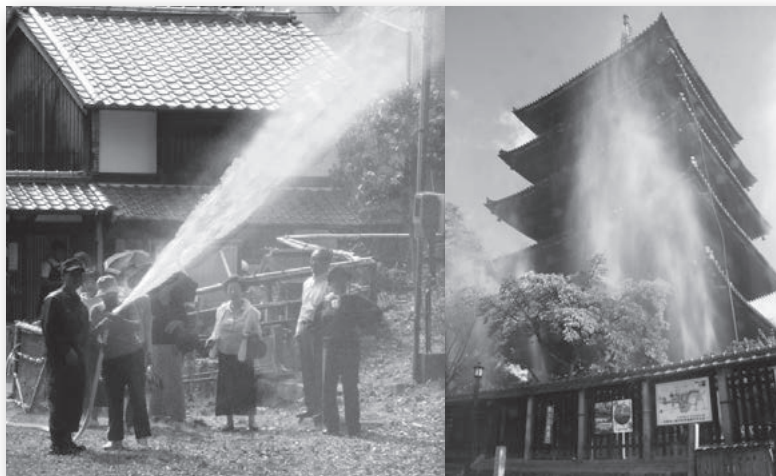
文化財とその周辺を守る防災水利(東山区) (左:市民用消火栓を使用した放水訓練 右:文化財延焼防止放水システム)
