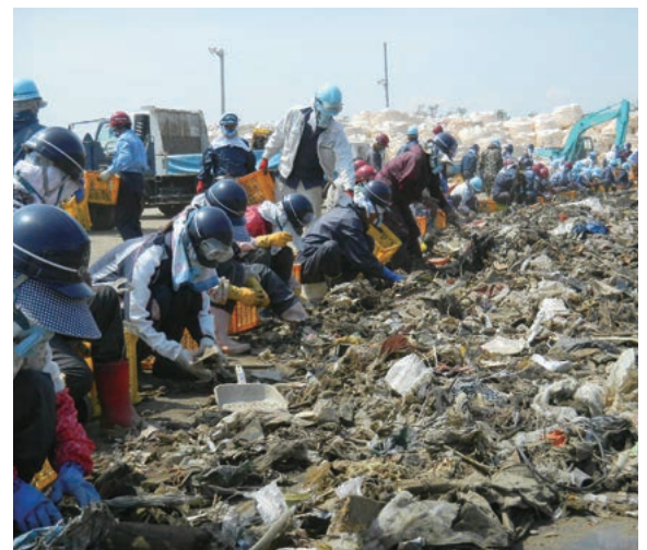
99%のリサイクル処理を実現した、独自の震災瓦礫処理
