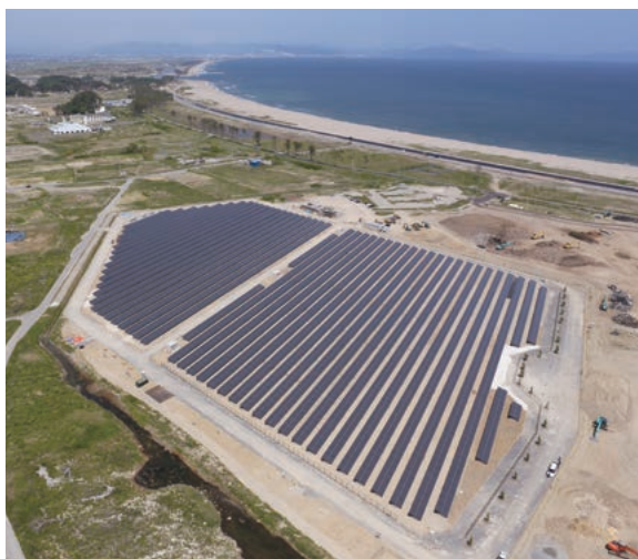
被災元地活用事業として進める「奥松島[絆]ソーラーパーク事業」
