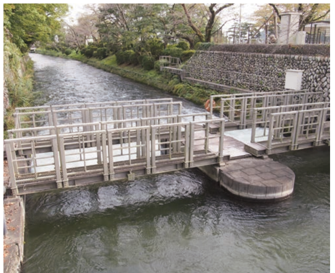
羽村取水堰(上段)と多摩川から分流した直後の玉川上水
