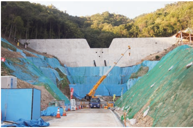
平成26年8月広島豪雨災害被災地では、砂防堰堤の整備が進行中
