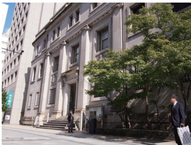
被爆した建物も復興資料として保存されている中心市街地
