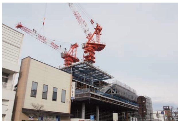
「円谷英二ミュージアム」や「図書館」等も入る市民交流センター工事現場
