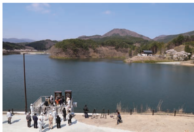
東日本大震災で決壊した藤沼ダムも復旧が完了
