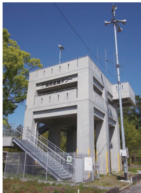
南海トラフの対策として整備された避難タワー(蛸原地区)
