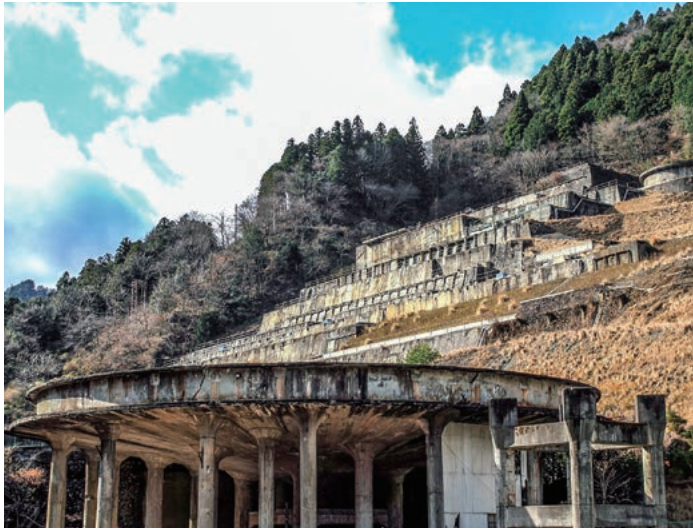
明延鉱山の選鉱施設として建設された「神子畑選鉱場跡」(朝来市)
