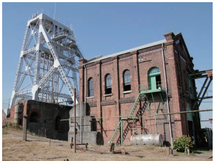
明治日本の産業革命遺産「万田坑第二豎坑櫓」(荒尾市)
