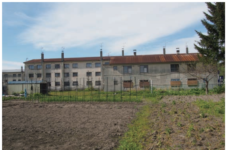
今も随所に残る「旧炭鉱住宅」
