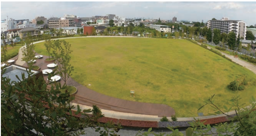
多目的施設元氣創造プラザと広場で構成される三鷹中央防災公園
