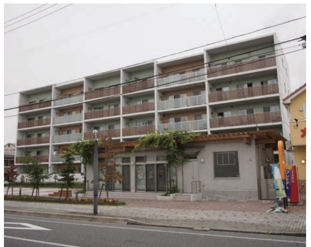
東日本大震災時に建物被害の多かった中心市街地に建つ災害公営住宅
