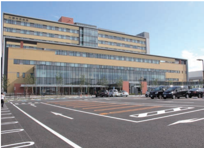
2014年に移転・開業した大崎市民病院(500床)は3年目で黒字に転換し全国から注目の的
