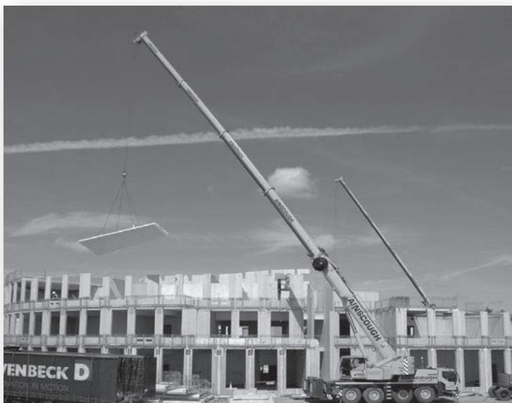
CLTパネルによる建て方(写真2)
