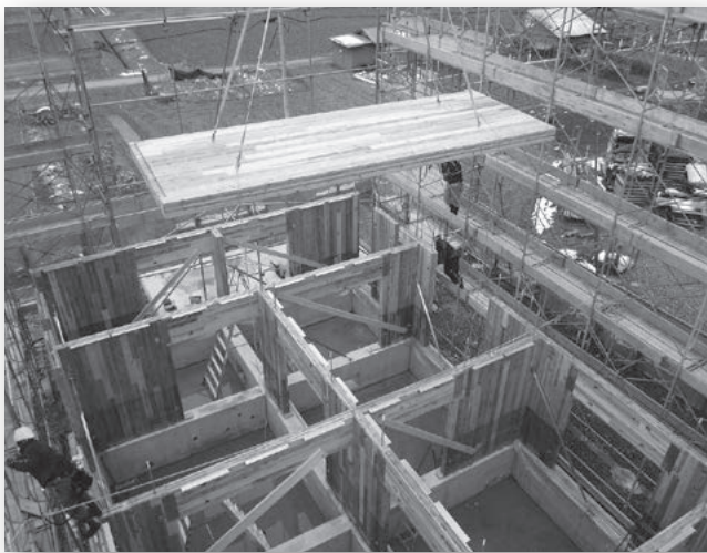
CLT建築の施工状況
