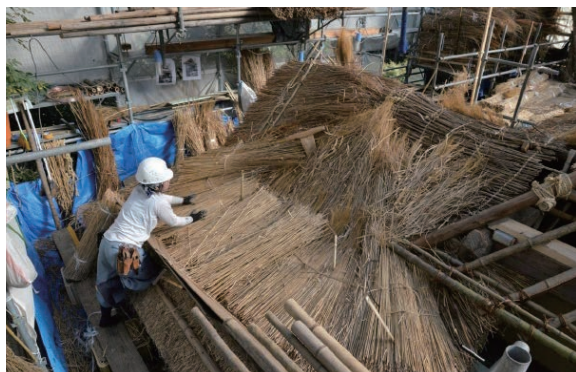
茶室「菅田庵」修理状況
