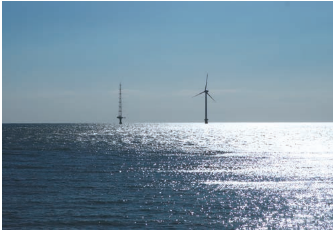
銚子沖の洋上風力発電
