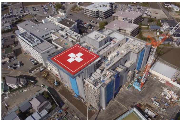
5月に開院される建設中の「阿南医療センター」(工事現場ドローン写真 平成31・2・1撮影)
