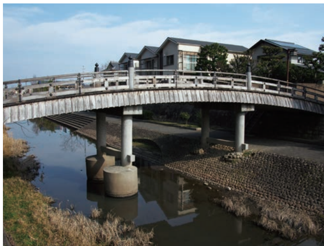
放生会で知られる放生川の太鼓橋(安居橋)
