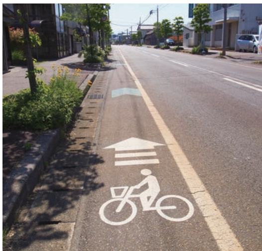
市街地の幹線道路に設置されている自転車用レーン
