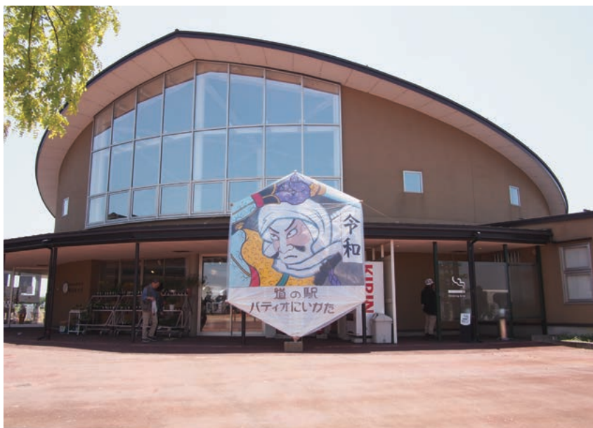
防災アーカイブ(刈谷田川氾濫)コーナーも備える「道の駅パティオにいがた」は近隣の人気スポット
