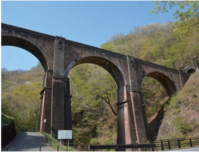
明治25年に完成した、国の重要文化財「碓氷第三橋梁（通称、めがね橋）」(安中市)
