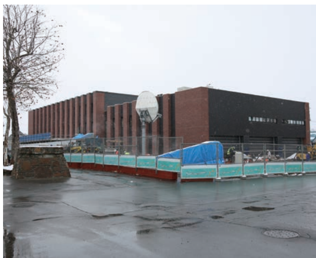
建設が進む市役所新庁舎(来春完成予定)
