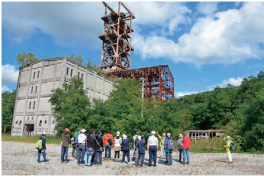
昭和35年（1960年）に建築された「住友弁別炭鉱立坑槽（すみともばんべつたんこうたてこうやぐら）」
