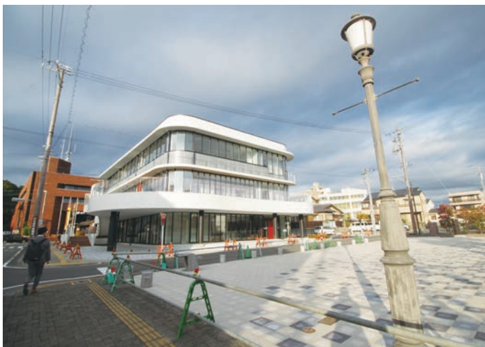
本年3月供用開始の庁舎東館は賑わい創出事業の拠点
