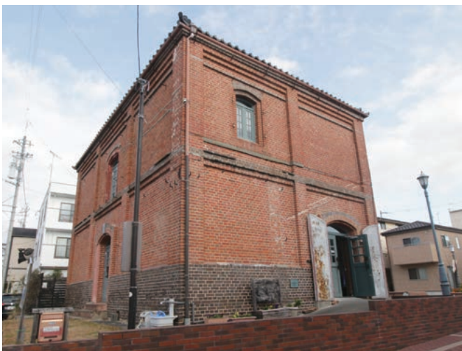
茶葉のブレンド作業などが行われた「赤れんが倉庫」(明治中期建築)
