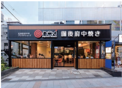
東京都千代田区神田小川町に設置した「府中市アンテナショップNEKI」
