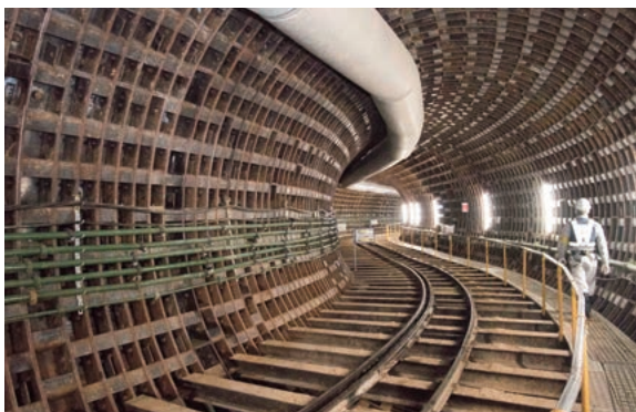
築造が進む高尾川の地下河川
