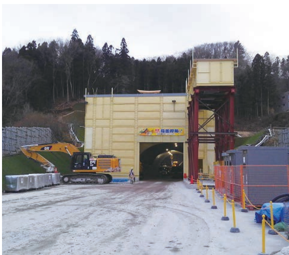
国道294号白河バイパスのトンネル工事現場(南湖裏)
