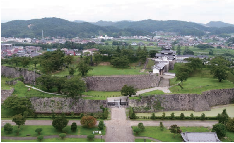
東日本大震災による崩落から復活した小峰城の石垣
