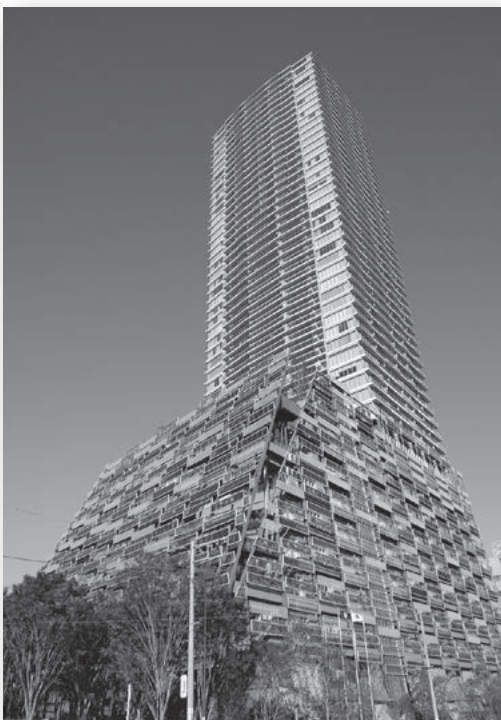
環境対策を先導する環境庁舎
