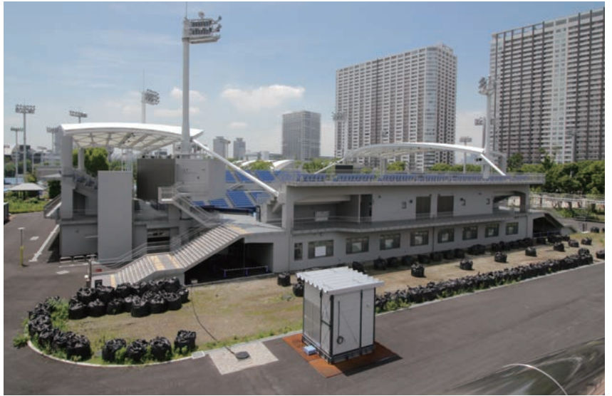
リニューアルが進む有明テニスの森(東京2020大会競技施設)
