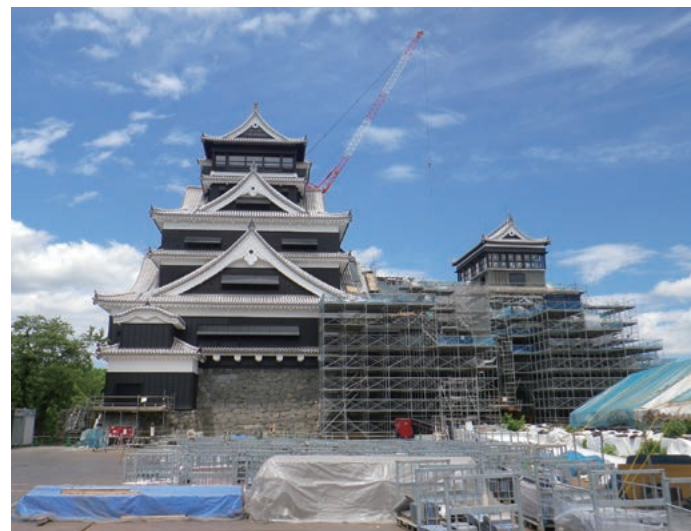
復旧工事が進む熊本城天守閣(熊本市)
