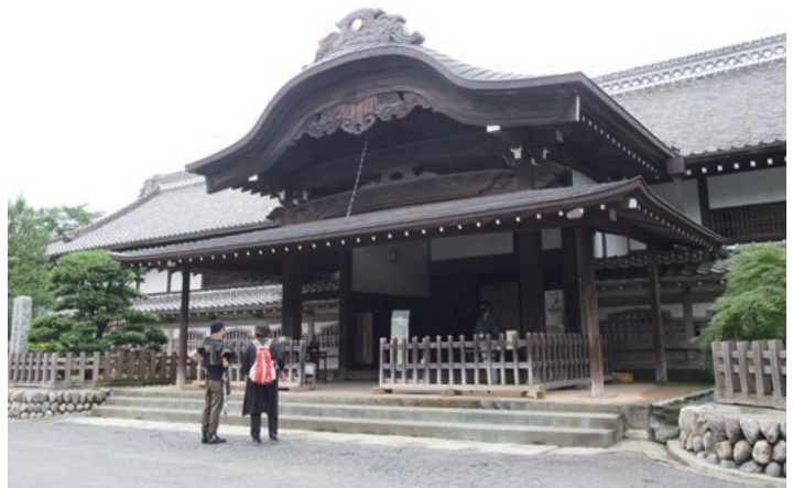
江戸末期に建てられた川越城本丸御殿は高知城と並び、全国に2棟しか現存しない本丸御殿
