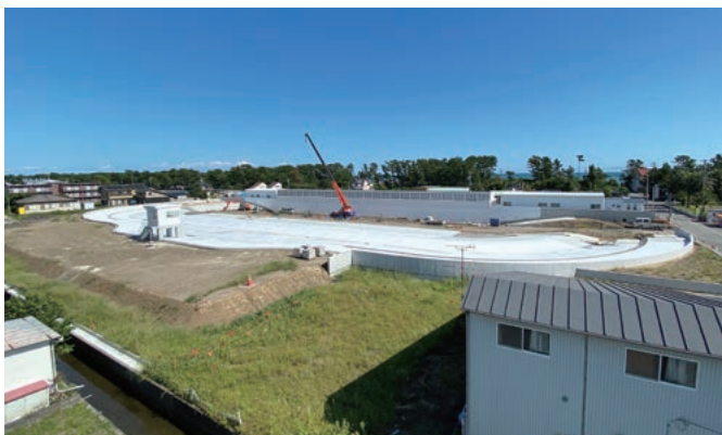
本年度完成予定のウエーブプール
