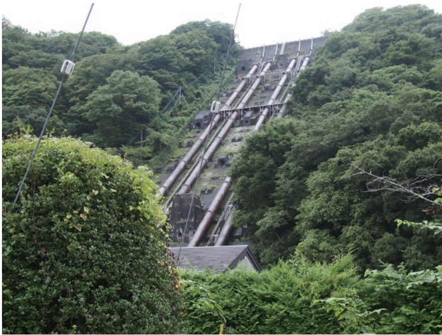
水力発電の銀座・桂川を象徴するハツ沢発電所施設は日本最大級の国重要文化財
