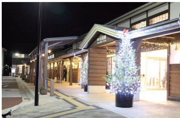
令和2年に整備したJR芸備線・備後庄原駅舎「庄原市交通交流施設」は鉄道駅・バスセンターの機能を併せ持つ交通の結節点
