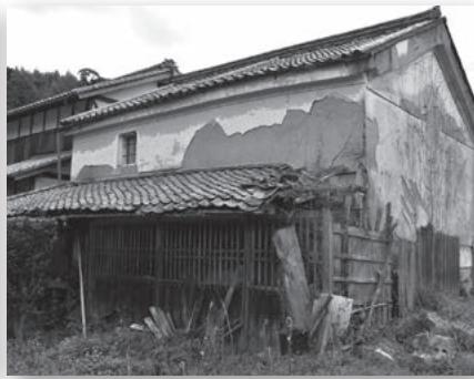
旧村上邸土蔵 改修前
