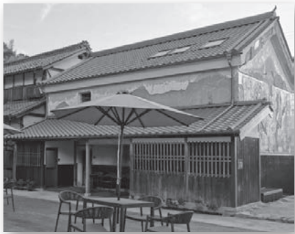
旧村上邸土蔵 改修後
