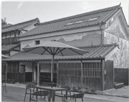
旧村上邸土蔵 改修後
