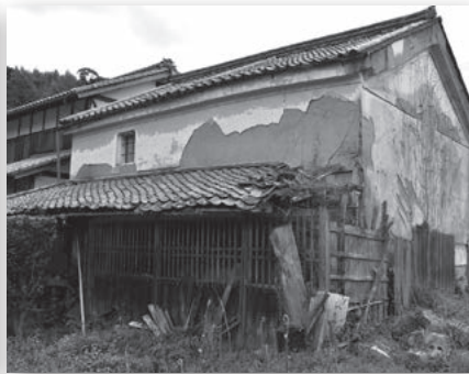
旧村上邸土蔵 改修前
