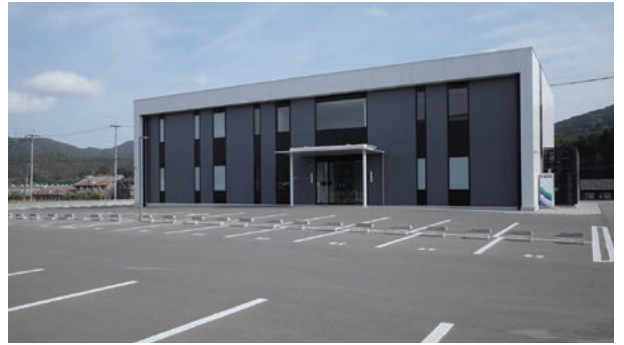
建設中から問い合わせが殺到するなど大人気!! 嬉野駅に隣接する「嬉野オフィスビル(企業誘致ビル)」
