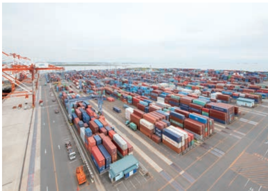
耐震強化岸壁を備えた鍋田ふ頭
