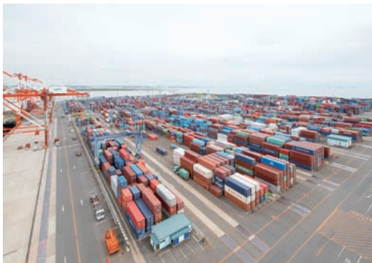
耐震強化岸壁を備えた鍋田ふ頭
