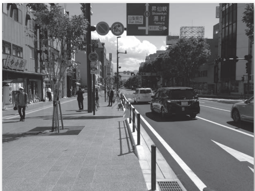
平和通り。アーケードの撤去をきっかけに街路の断面を変更し、歩道空間を拡張した
