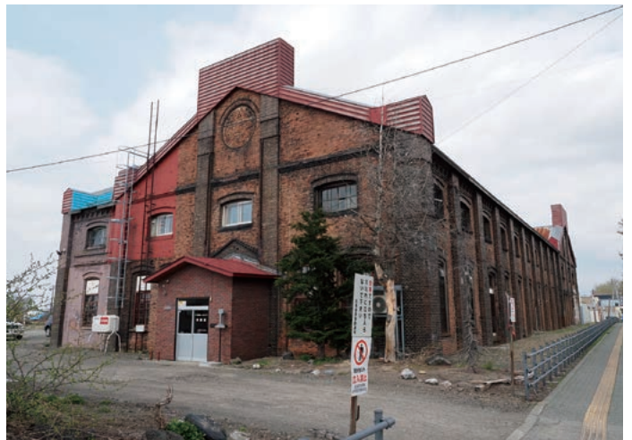
北海道内の鉄道線路を一手に製造している岩見沢レールセンター。明治32年竣工、鉄道のまち・岩見沢のシンボリック建物(近代化産業遺産)
