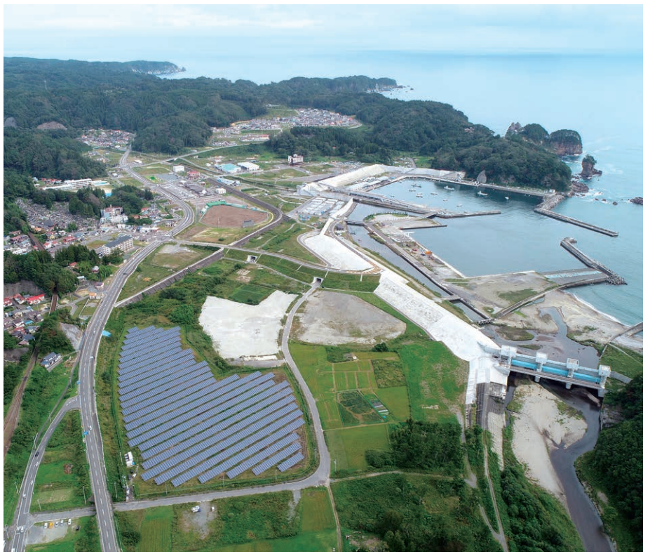
田老地区に築かれた防潮堤の高さは第一線堤が14.7m、第二線堤は10.0mに達する
