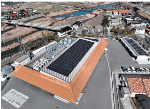
PPA事業により太陽光発電設備を導入した「にいみ〜る」(新見市学校給食センター)
