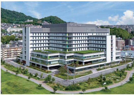
市立総合医療センター（令和4年9月開院）
