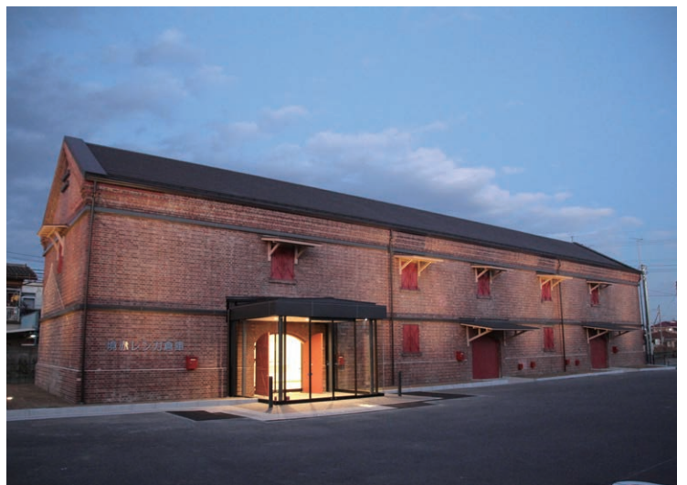
改修工事を終え、地域のにぎわい創出の場へと変貌を遂げた「境赤レンガ倉庫」(伊勢崎市)
