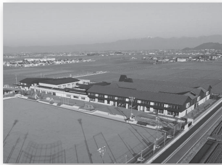
平成27年度に竣工した桐原コミュニティエリア
