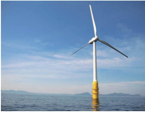
国内初の商用規模浮体式洋上風力発電施設「はえんかぜ」
