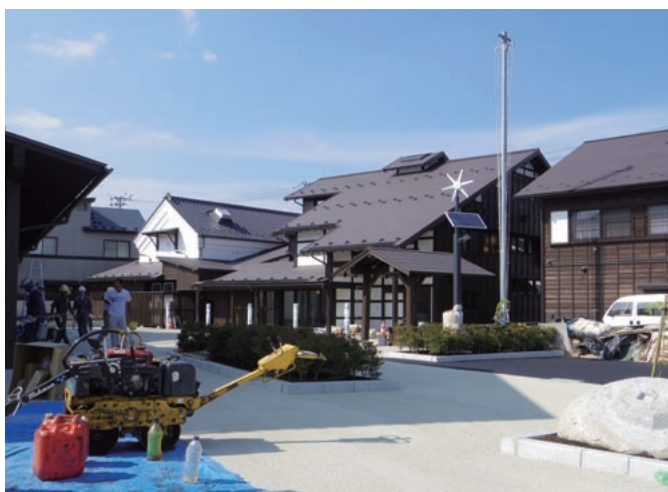
地域の交流拠点として、新たな観光交流拠点として期待される「もりおか町家物語館」（工事中の写真）
