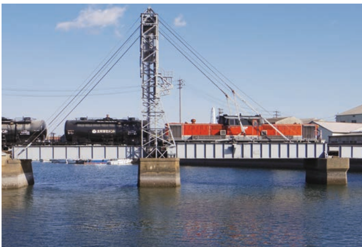
昭和6年完成の末広橋梁（跳ね上げ式、国指定重文）と潮吹き堤防の重文コンビは、コンビナートの新たな観光コンテンツ
