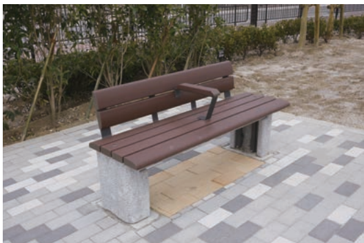
健康遊具も並ぶ防災公園。ベンチの下には災害時の煮炊き用カマド設備
