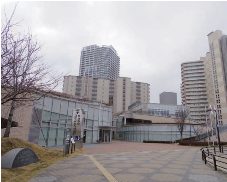
コミュニティプラザ、保健センターなど公共施設の周囲に高層住宅が並ぶ南千里丘地区
