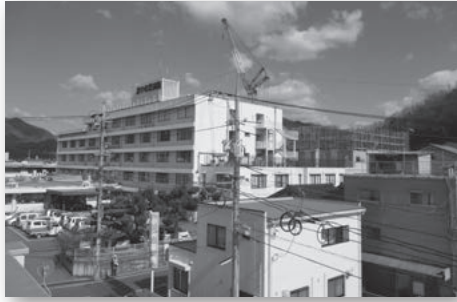
現在の府中市民病院(手前)と建設中の新病棟(奥)
