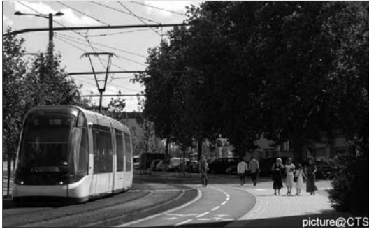
トータルデザインの都市交通（芝生軌道・自転車専用道路・歩行者空間） 写真提供：ストラスブール都市共同体
